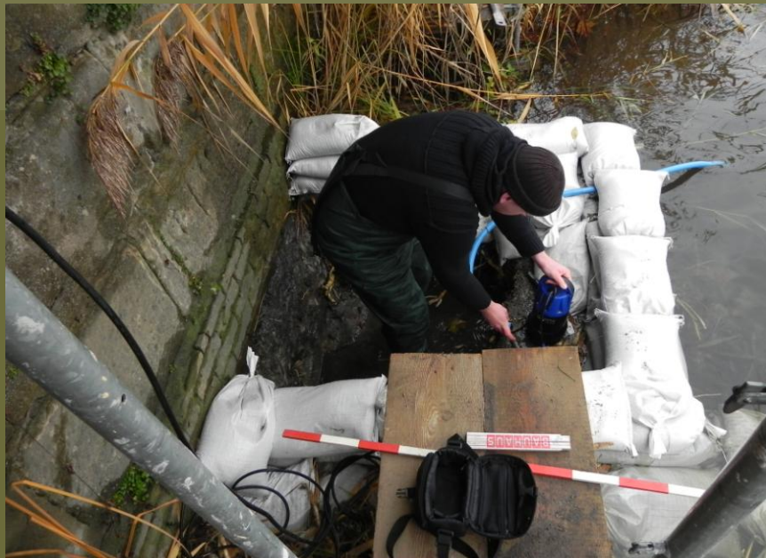
Abb. 4: Arbeiten im stehenden Wasser am Außenbereich der Ufermauer (Schurf 2). Foto: Dr. D. Kühnholz.
